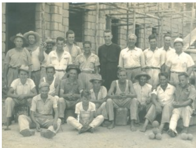
Trabalhadores na construção da Casa de Retiro (Foto: Acervo Jonas Cadorin)
