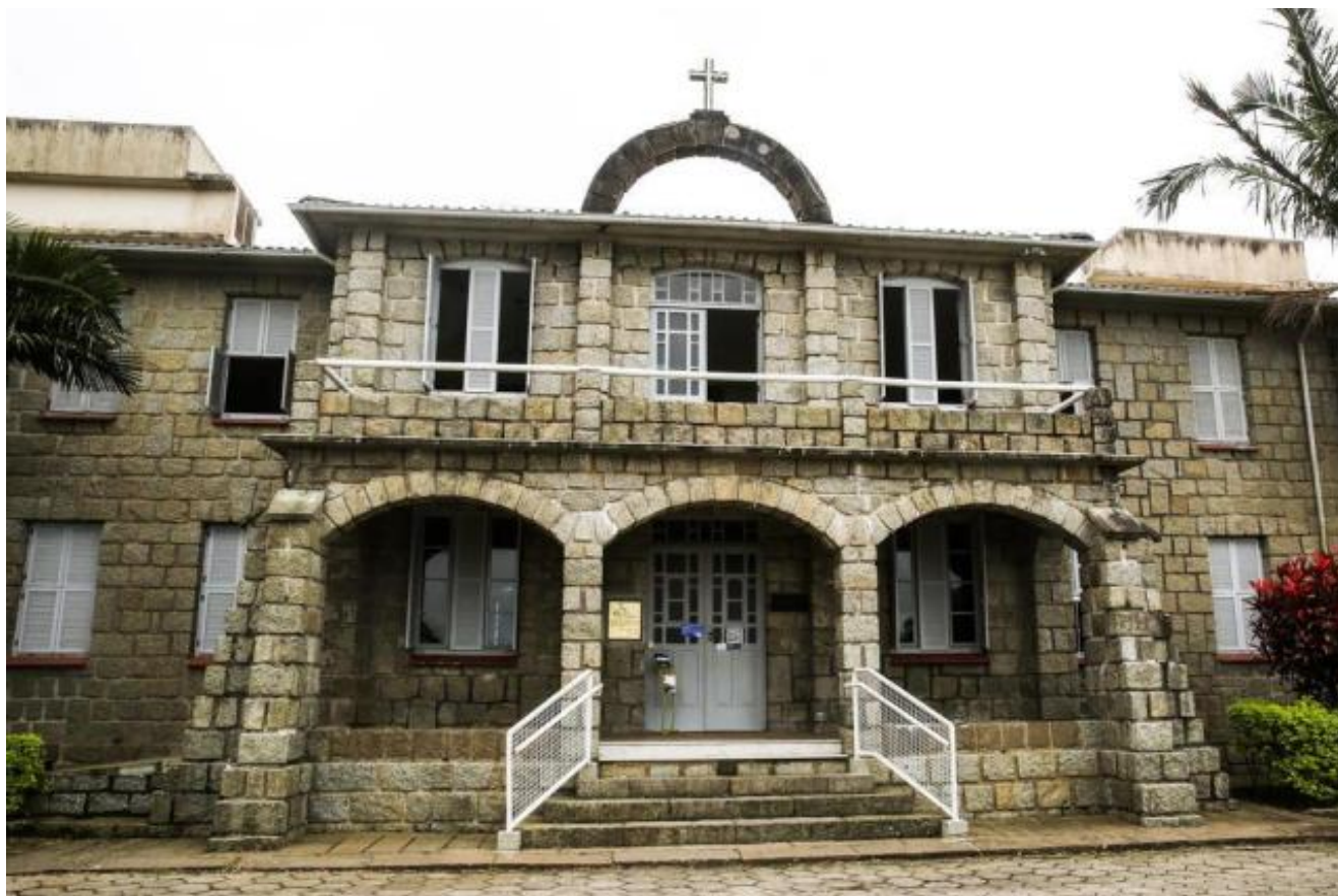
Estrutura inaugurada em 1956 foi construída com pedras do próprio morro e tijolos transportados pelo mar Foto: Diorgenes Pandini / Agencia RBS
